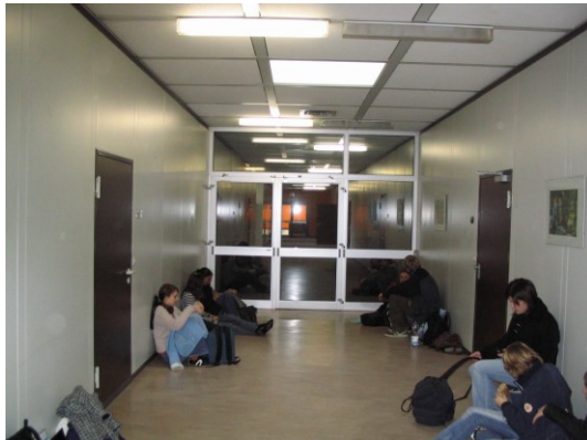
Bild: 06 geschlossene Rauchschutztür
